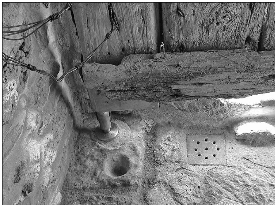
Εικ. 5. Οι νέοι στροφείς του Νοτίου θυροφύλλου της κεντρικής πύλης της Κάτω Πόλης.
