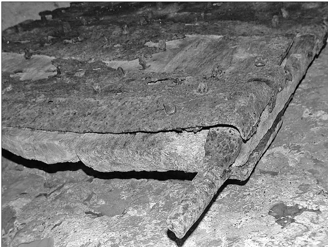
Εικ. 1. Φθορές νοτίου θυροφύλλου της κεντρικής πύλης της Κάτω Πόλης.
